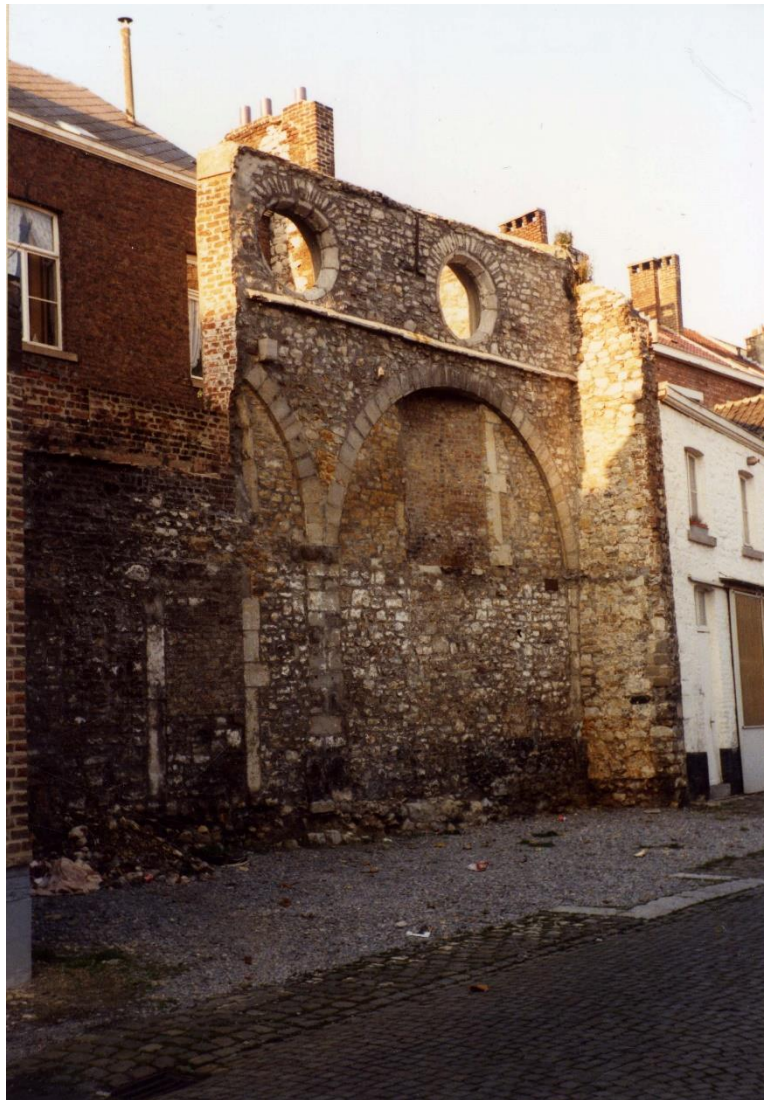
Figure 1: The only remaining wall of Église Saint-Martin d'Outre-Meuse.
